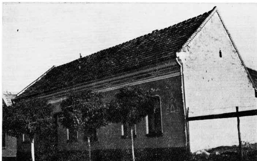
20. České stavení se soudobou výzdobou na fasádě. Kruščica (o. Vršac), ul. maršála Tita 88.
