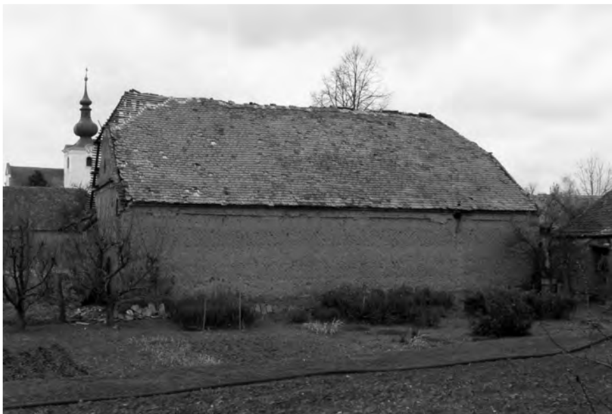
Stodola z hliněných válků. Slup (okr. Znojmo). 2010, foto J. Matuszková.
