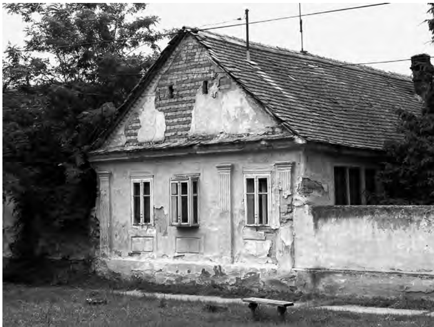
Zděný dům kombinující ve štítě pálenou a nepálenou cihlu. Veliko Središte, Banát (Srbsko). 2011, foto M. Válka.
