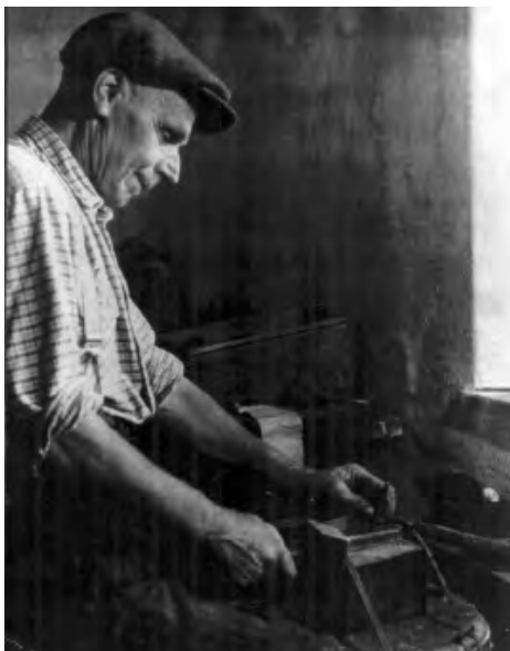
Ruční výsek rašplového zubu pilníkářem Antonínem Otavou, Křižánky. 1955. Archiv Souboru lidových staveb Vysočina Hlinsko.
