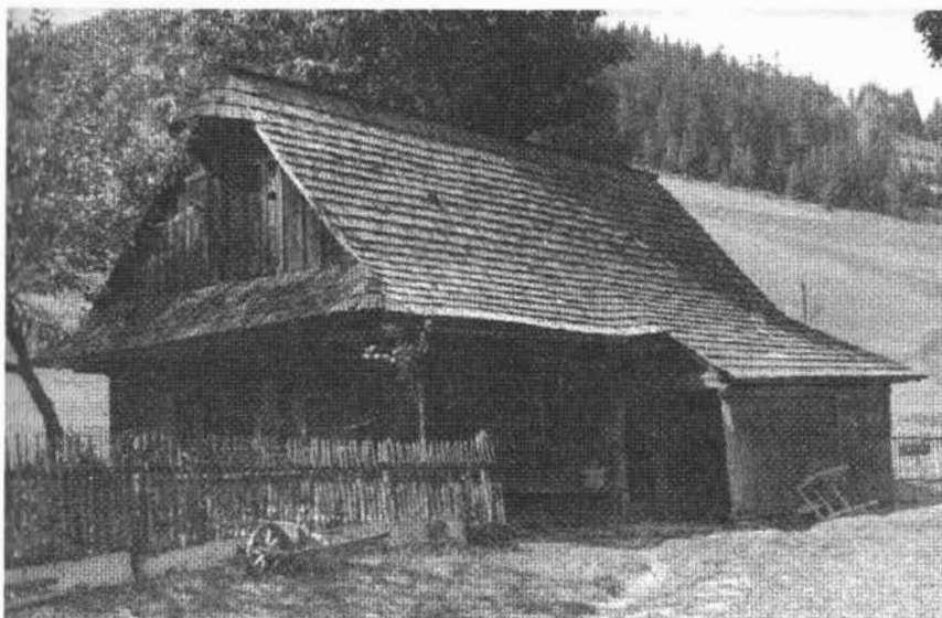
Nový Hrozenkov čp. 532, údolí Bzové, o. Vsetín. Roubený valašský dům s podlomením, kuklou, podsínkem, z r. 1836. Foto: A. Tenzer, 1942-1943
