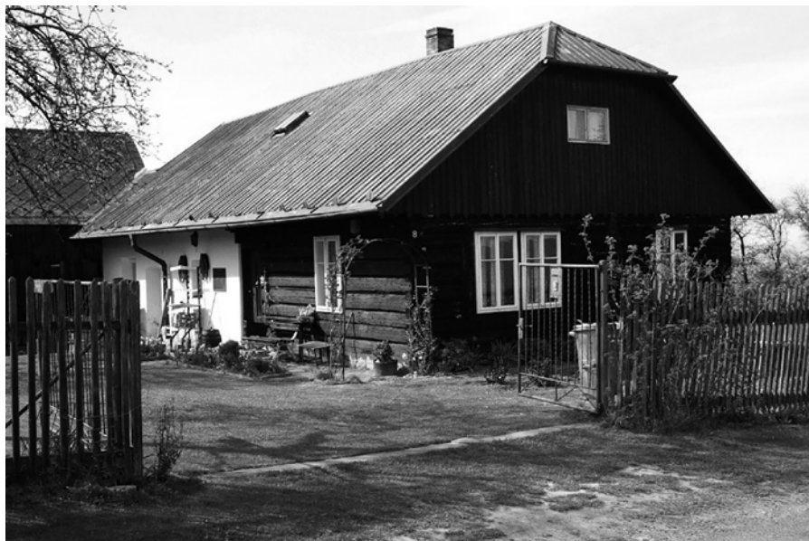
Současný stav domu Karla Ježe v Lazech čp. 8. Místnost s oknem úplně vpravo byla kartáčníckou dílnou. Foto H. Sedláčková.
