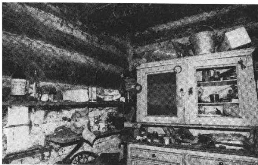
Stará kuchyně. Roubená stěna s povalovým stropem
