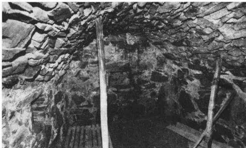
Klenba kamenného sklepa pod starou kuchyní.
