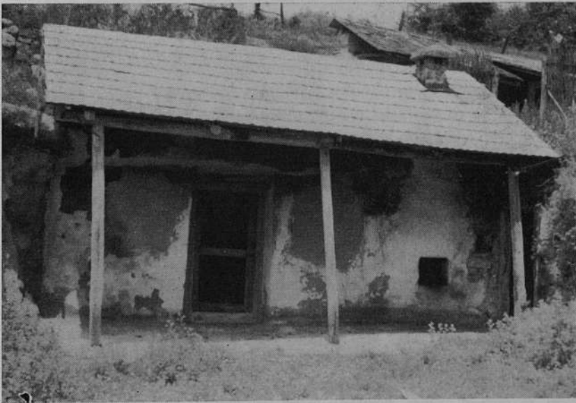
Obr. č. 26. Lišov. Pivnica, bývalý byt Vozárovcov (1969).
