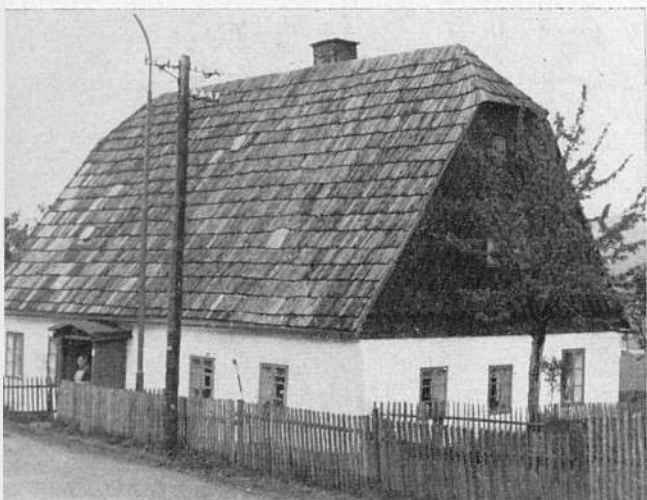
7. Massivbau. Brandov, NC 40 (Bez. Mos), Photo St. Šulc 1968.
