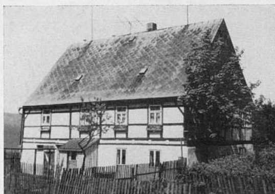
13. Einstöckiges Fachwerkhaus. Brandov, NC 86 (Bez. Most), Photo St. Sulc 1968.
