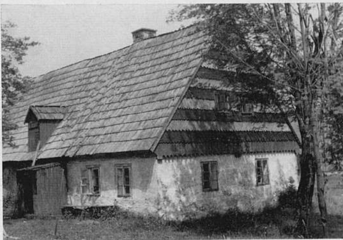
28. Wohnstallhaus. Osek - Nová Ves, NC 44 (Bez. Teplice), Photo J. Vareka 1955.
