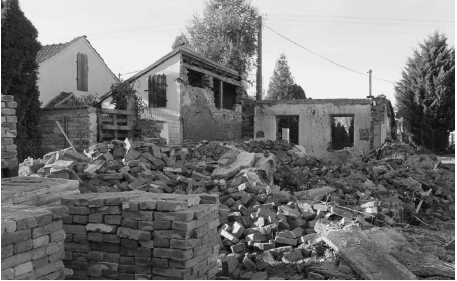
Obr. 1. Demolice domu čp. 177 ve Strachotíně. Foto Jana Křivánková, 2020.
